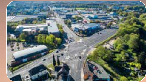
Umbau Straßenkreuzung Trecknase B 229 / B 51
